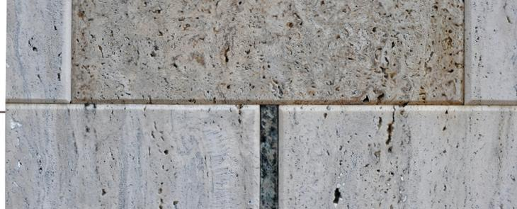
Afin de disposer les pierres à leur place sur l'édifice, elles sont numérotées puis reportées sur un plan à échelle réduite : c'est le calepinage/calepin d'appareil. La pose des blocs de pierres se fait principalement avec un mortier de chaux, pour ne pas rompre le circuit air/ eau entre les blocs. Ils existent plusieurs méthodes de pose :
