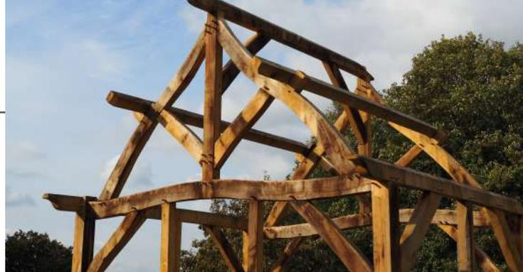
Le-la charpentier·ère assemble ensuite les pièces qui composent la charpente au sol afin de corriger d'éventuels détails techniques.
